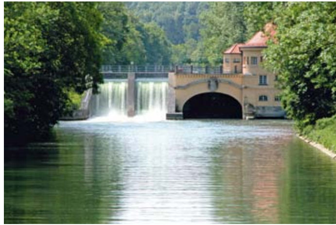
Eine lokale Energiequelle in München: Das Wasserkraftwerk Isar I
