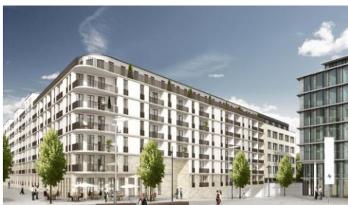
Das Objekt Pariser Höfe in Stuttgart ist Teil des Projekts „Stuttgart 21“ und wurde für die Versorgungsanstalt der deutschen Bühnen erworben.
